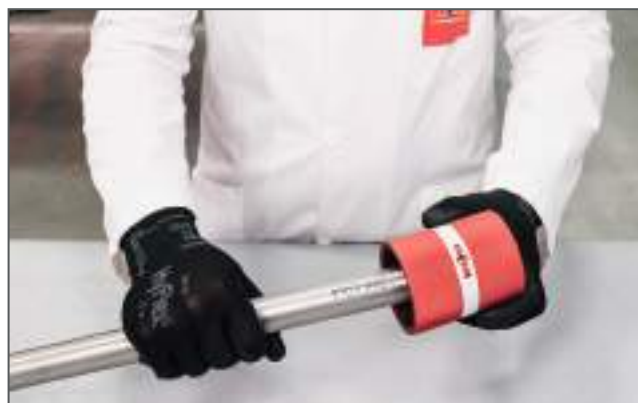
Sbavatura del tubo / Deburring the pipe
